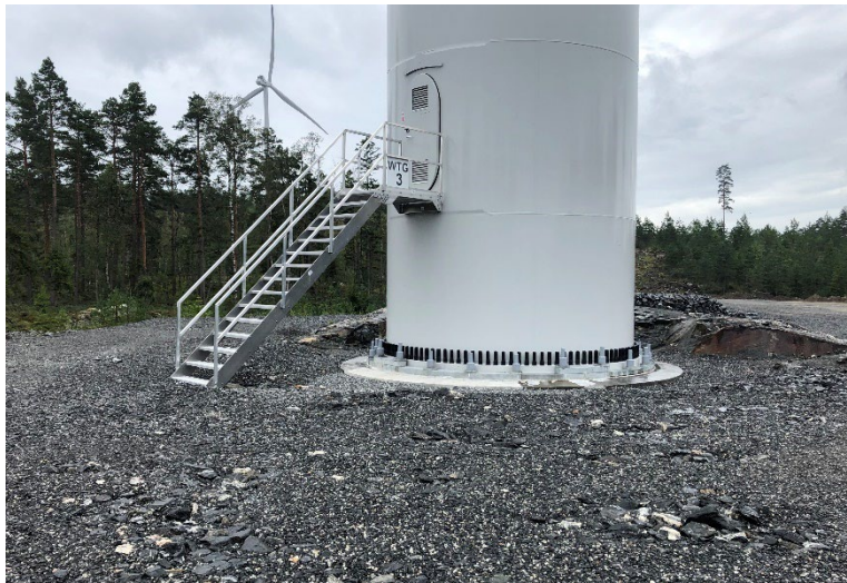
Figur 8 Ett färdigt fundament, merparten dolt under mark
