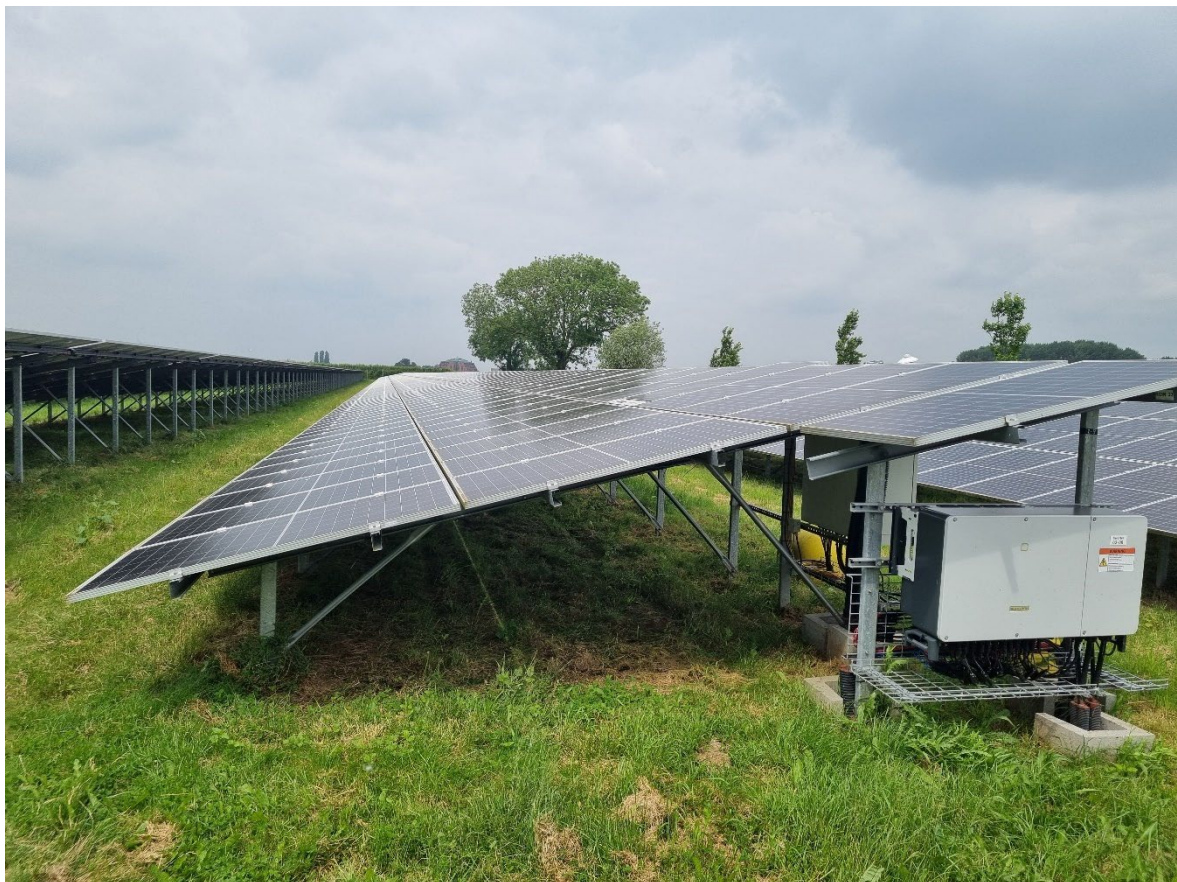
Figur 107 Solceller med 'fixed tilt' samt växelriktare
