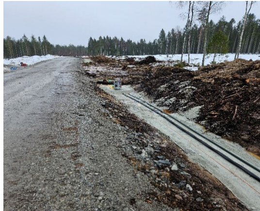
Figur 13 Kabelförläggning, Munkhyttan vindpark, Lindesberg kommun
